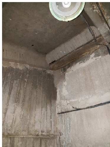
3.4 paveikslas. Gelžbetoninės konstrukcijos paveiktos drėgmės
