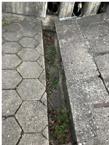
3.7 paveikslas. Drėgmės pažeistas cokolis ir netinkamai įrengta vandens nuvedimo sistema
