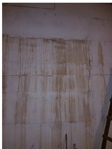
3.5 paveikslas. Šiaurinės pastato sienos besiribojančios su gruntu pažaidos nuo drėgmės
