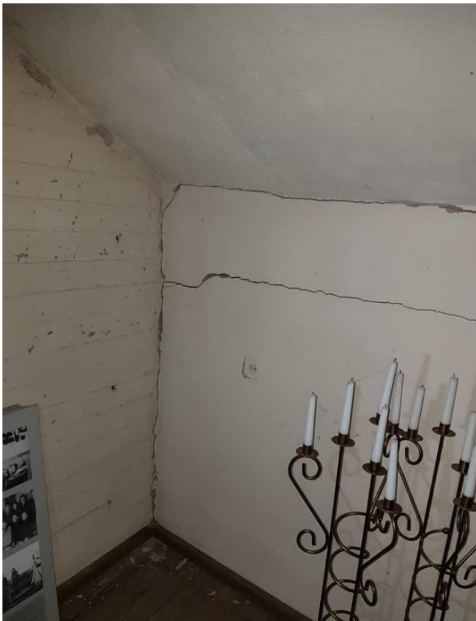
15 pav. Suskilusios nelaikančios pertvaros
