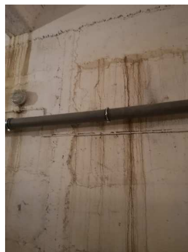
3.5 paveikslas. Šiaurinės pastato sienos besiribojančios su gruntu pažaidos nuo drėgmės
