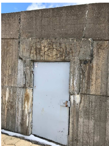
3.6 paveikslas. Fasadinių konstrukcijų pažaidos
