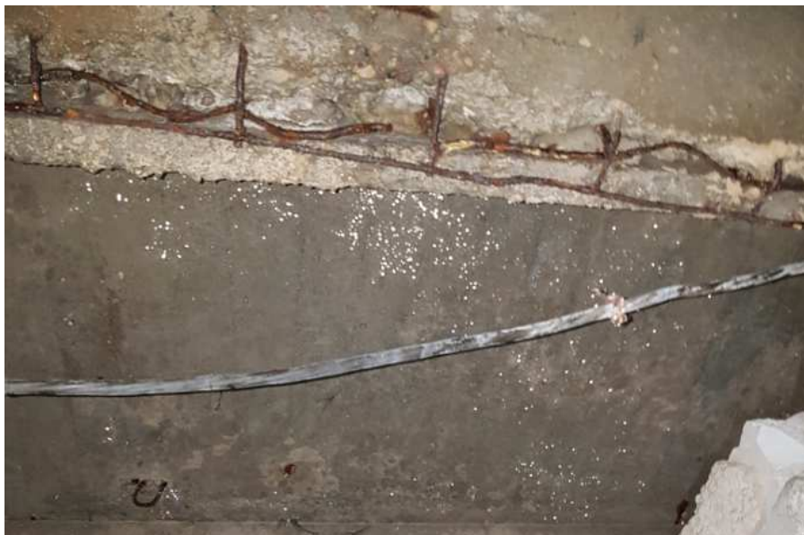
19 pav. Plokštė pažeista drėgmės poveikio
