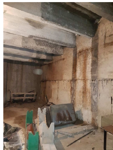
3.4 paveikslas. Gelžbetoninės konstrukcijos paveiktos drėgmės
