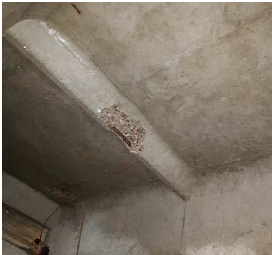
18 pav. Pažeistas apsauginis sluoksnis
