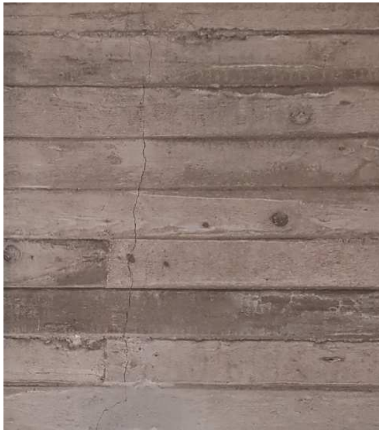
12 pav. Įtrūkimai vidinėje laikančioje sienoje
