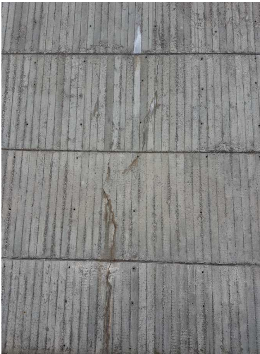
13 pav. Įtrūkimai išorinės sienos monolitiniame gelžbetoniniame apdailiniame sluoksnyje
