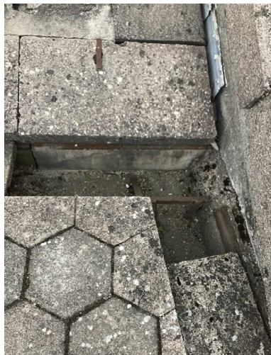
3.7 paveikslas. Drėgmės pažeistas cokolis ir netinkamai įrengta vandens nuvedimo sistema
