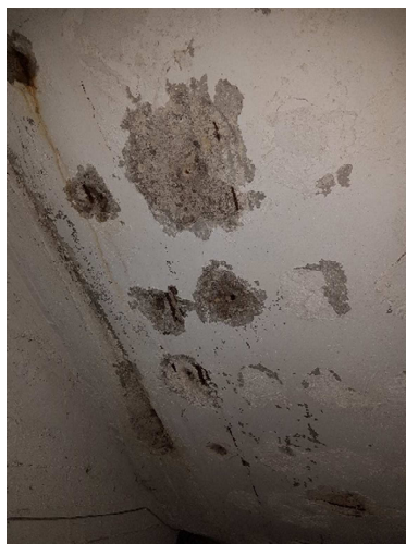
3.3 paveikslas. Gelžbetoninių pastato konstrukcijų pažaidos
