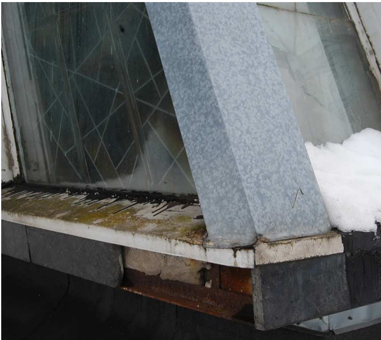
16 pav. Pažeista stiklinės sienutės apdaila
