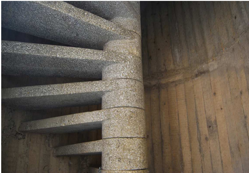
23 pav. Vidiniai gelžbetoniniai laiptai
